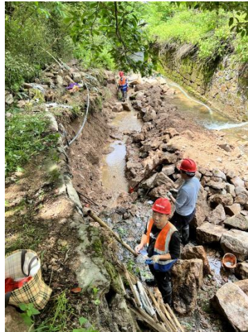
施工期排水工作
